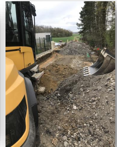
Travaux rue Paul Gilbert
